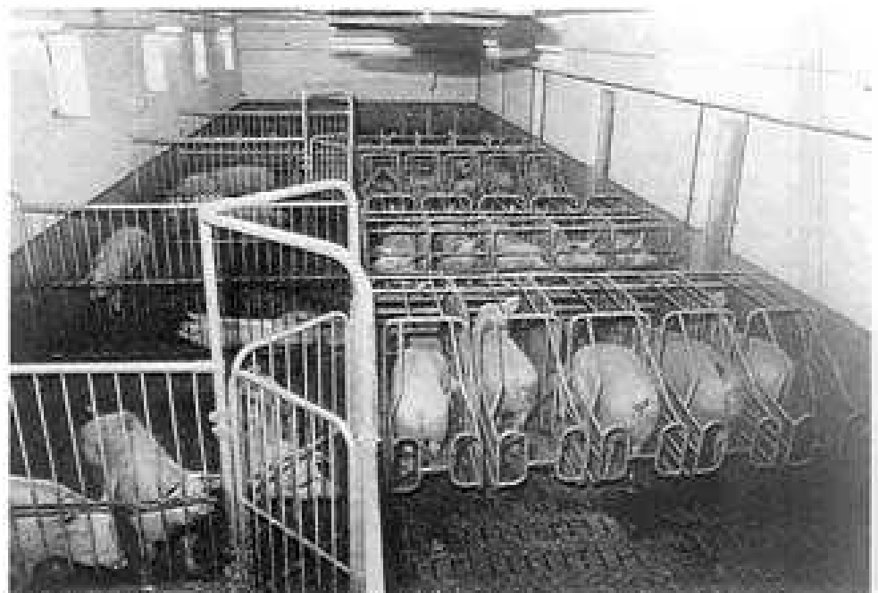
Bild 9: Deckstall mit Beton-Flächenspaltenboden, Kastenständen und Buchten
