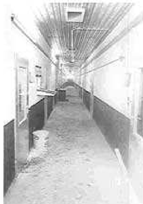
Bild 5: Zentraler Erschließungsgang des Stalles
