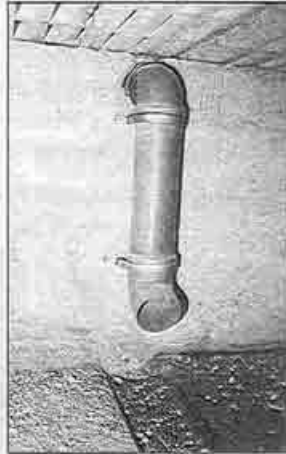
Abb. 13–15: Über ein Zentralrohrsystem wird die Gülle in eine Vorgrube abgelassen (links). Eine Tauchmotor-Schneidpumpe fördert die Gülle in den Hochbehälter und über eine stationäre Spüleleitung (Mitte) zu Spülöffnungen in den einzelnen Güllekanälen (rechts).
