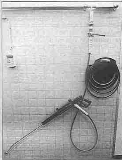
Abb. 9: Stationäre HD-Leitung mit Schnellkupplung für HD-Lanze vor jedem Abteil.
