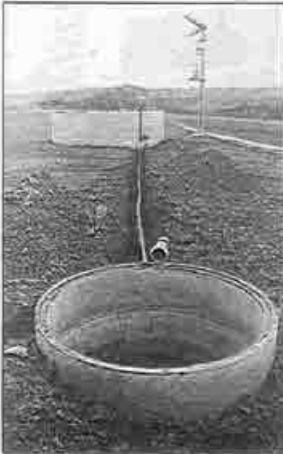
Abb. 13–15: Über ein Zentralrohrsystem wird die Gülle in eine Vorgrube abgelassen (links). Eine Tauchmotor-Schneidpumpe fördert die Gülle in den Hochbehälter und über eine stationäre Spüleleitung (Mitte) zu Spülöffnungen in den einzelnen Güllekanälen (rechts).
