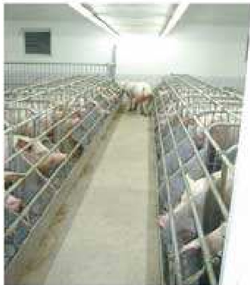
Abb. 7: Sucheber im Gang vor den Sauen. Über dem Gang Zuluftkanal mit Porenplatten, daran befestigt die Beleuchtungskörper. (je eine Speziallampe pro drei Sauen)
