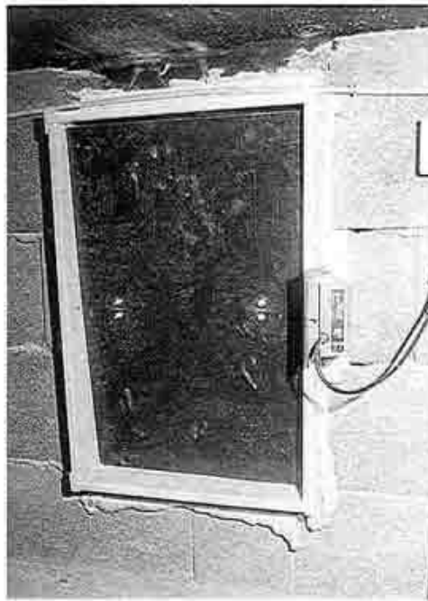
7 Klappenstellmotor im einbaufertigen Mauerrahmen, Stellklappe geschlossen
