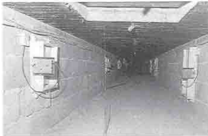
6 Blick in den zentralen Entsorgungsgang unter dem Erschließungsgang mit den Klappenstellmotoren. Oben vorn: Revisionsöffnung. Am Kanalboden: Wasserleitung zum Vorwärmen des Trinkwassers.
