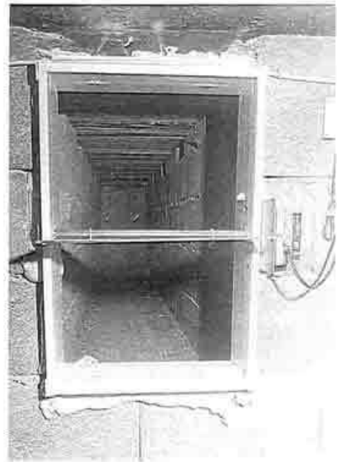
8 Geöffnete Stellklappe und Abluftkanal mit Absaugschlitzen im Wartestall
