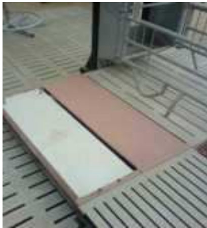
Beheizbare Polymerzement-Platten 40 x 120 cm mit WW-Heizung (Edelstahlrohr)
