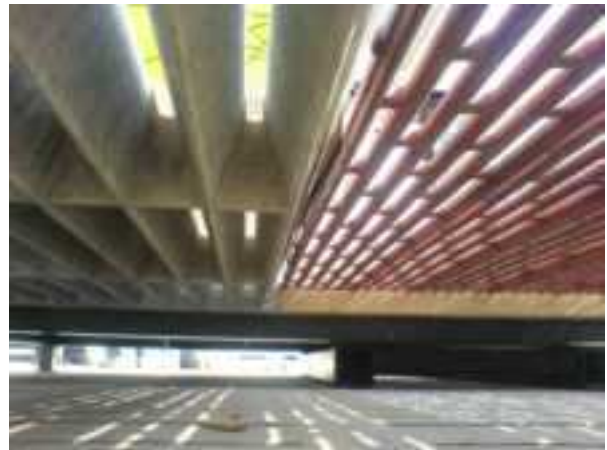
Spaltenboden von unten Dreieckprofil mit guter Unterbodenhygiene beim Polymerzement-Spalten
