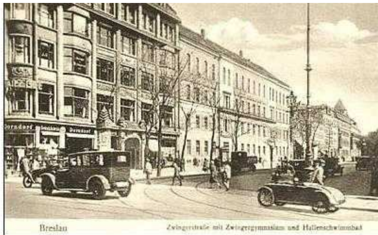
Nordseite der Zwingerstrasse
